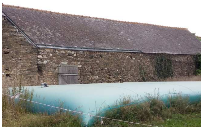
Réserve incendie existante sur le site du GAEC du Quinquis
