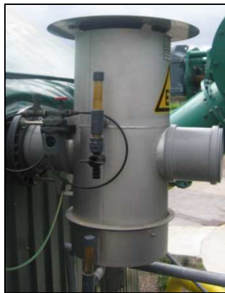
Soupape de sécurité surpression/dépression
